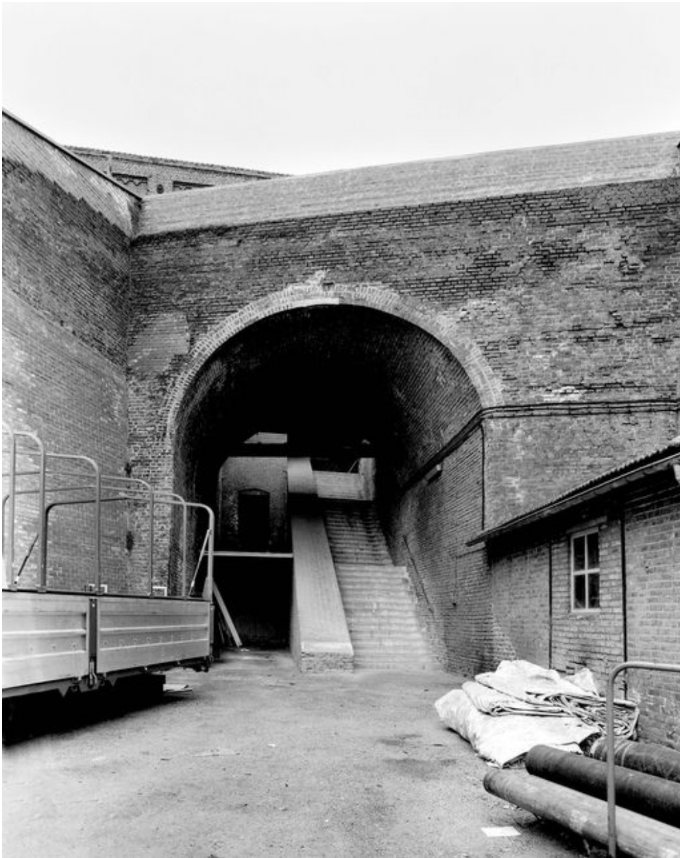
Tunnel abritant l'escalier qui relie le tissage à la bâcherie. Etat en 1991.
