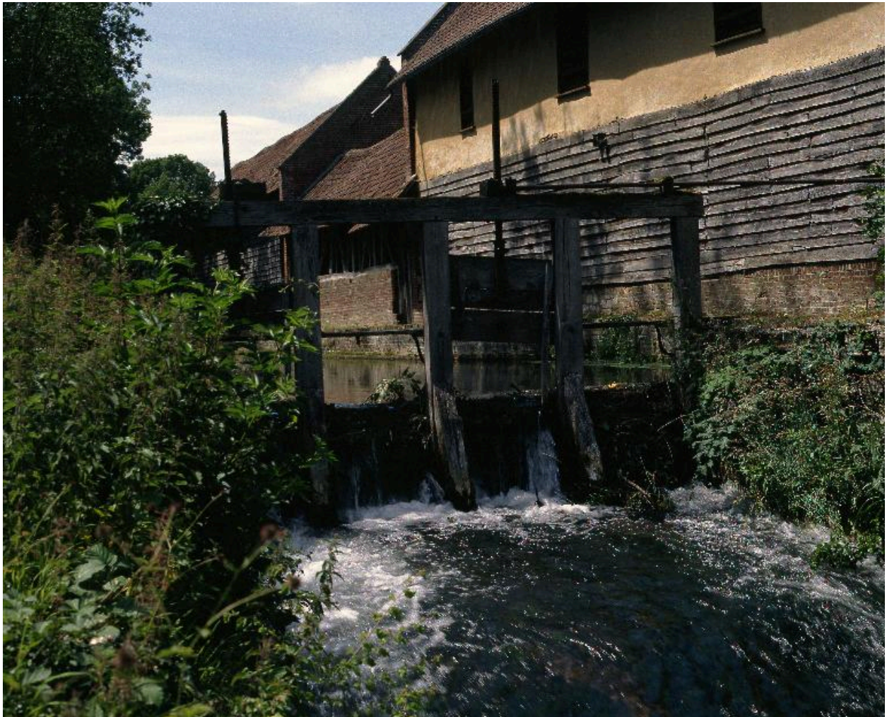
Vue du déversoir.
