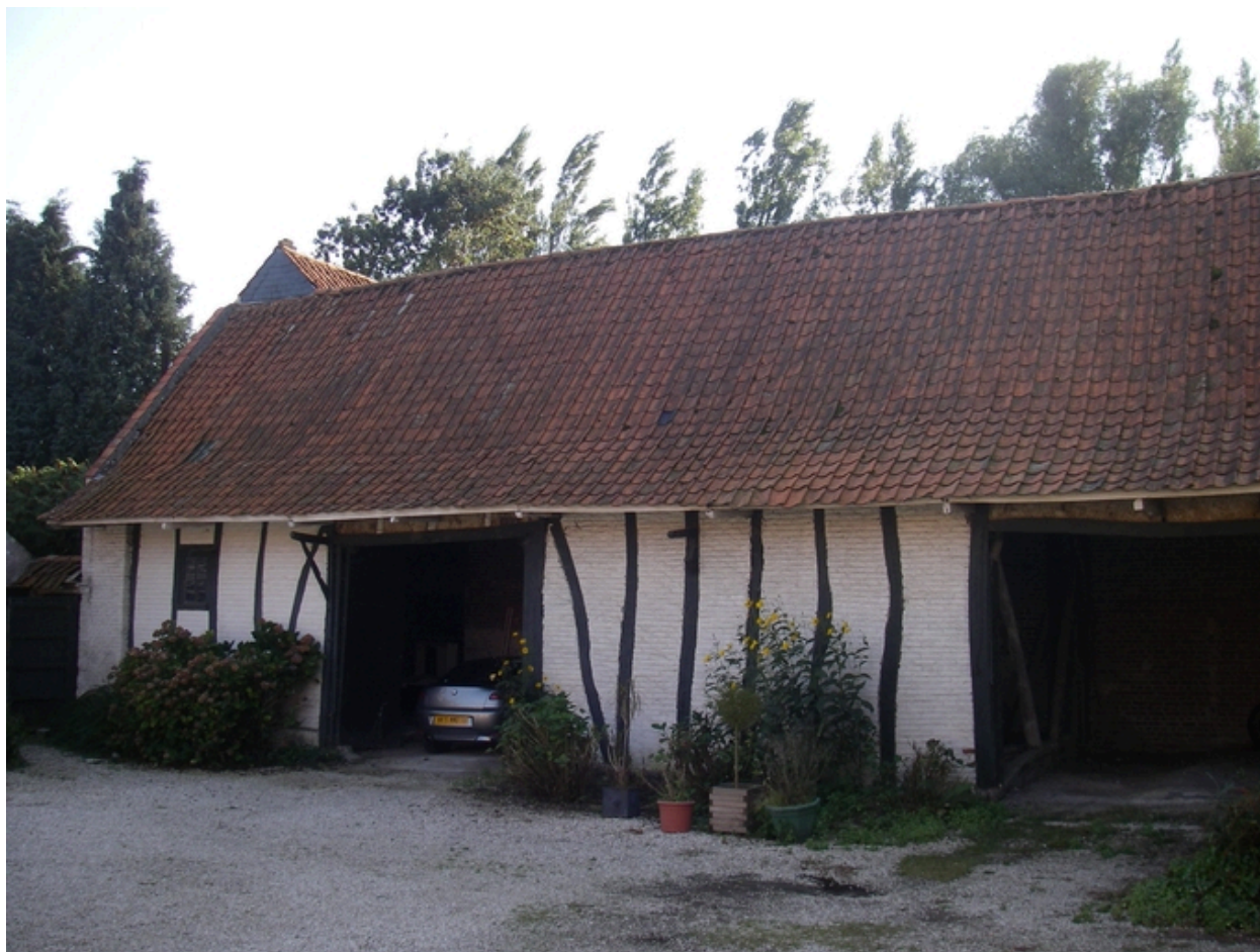
Grange de ferme (vestige de pan de bois et torchis) 562, rue Stanislas-Machynia, vue depuis cour.
