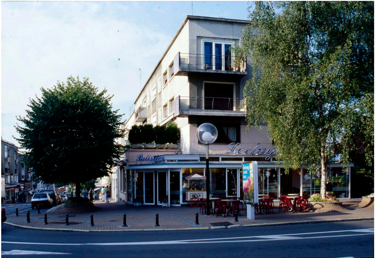
Vue de l'élévation Nord de l'immeuble prise depuis la place des Nations.
