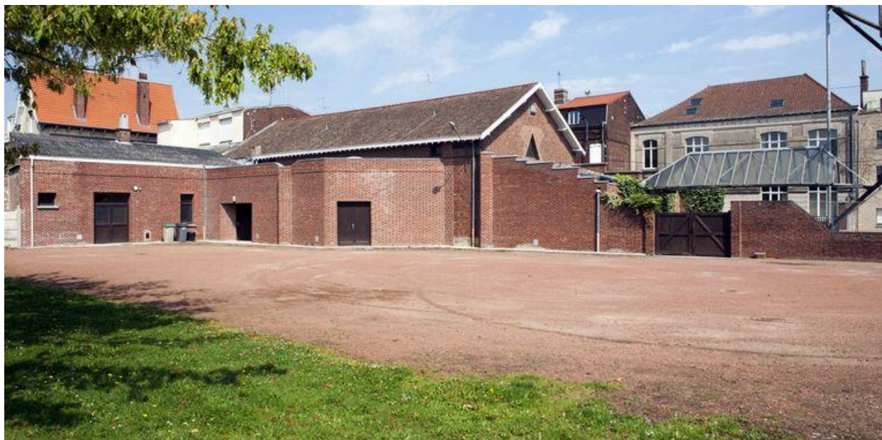
Façade côté sud.
