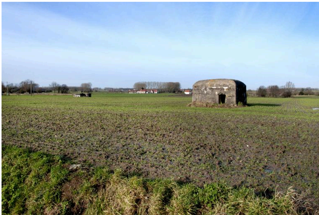
Vue générale vers le nord-ouest. Au second plan, une casemate à mitrailleuse (IA59004897)
