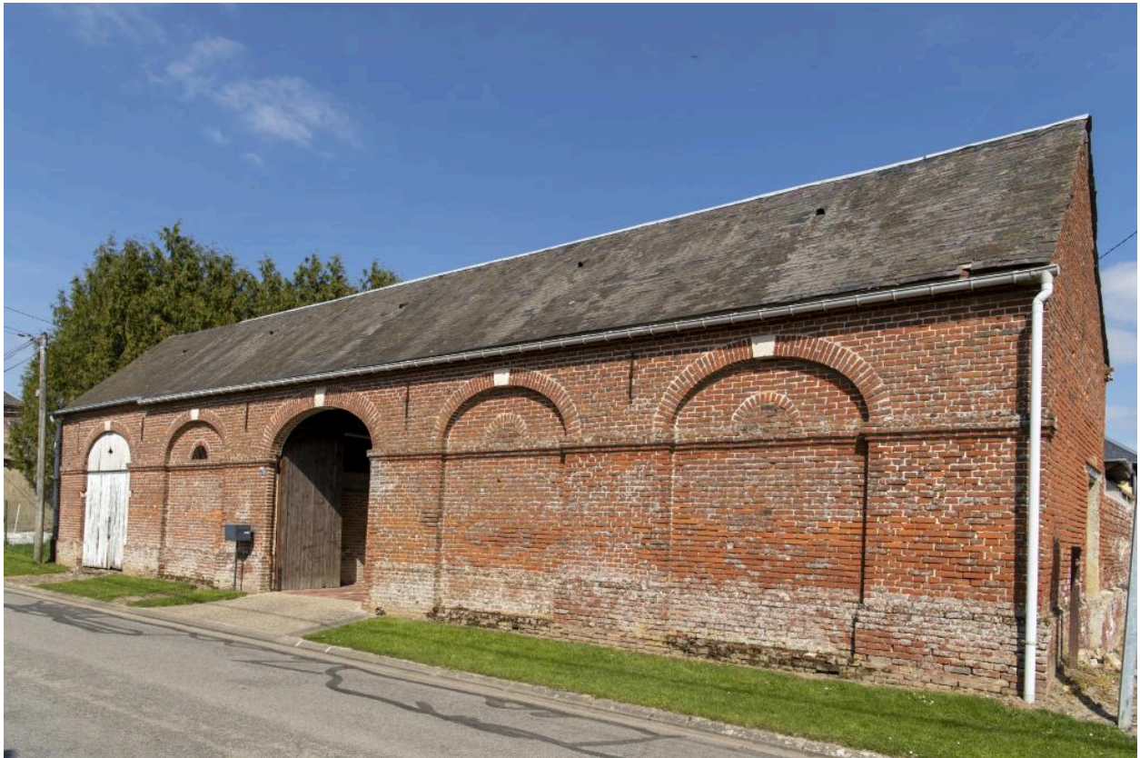
Façade de grange et entrée charretière sur rue, rythmée par des arcs surbaissés, n°18 rue Principale, vue depuis l'ouest.
