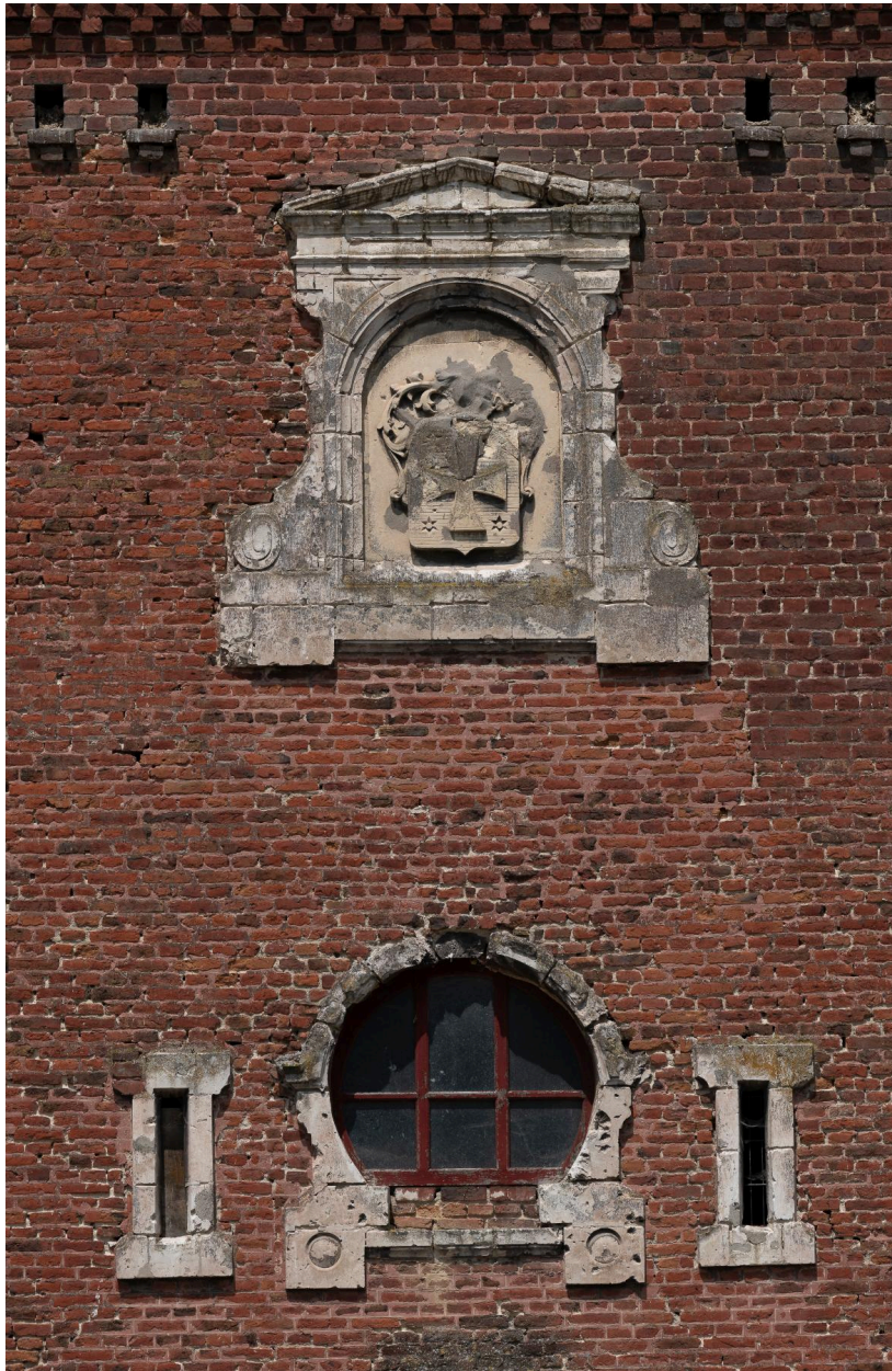
Détail des éléments présents sur la façade intérieure de la tour-porche.
