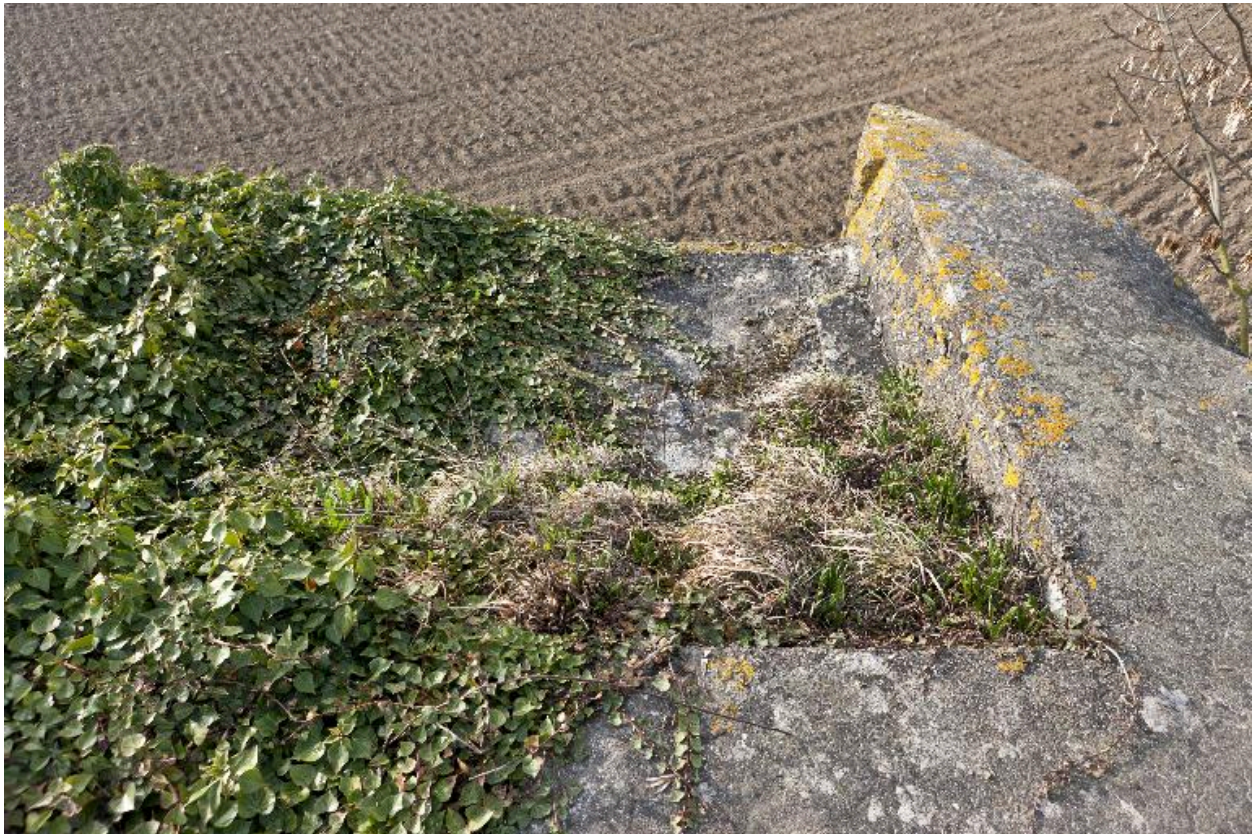
Emplacement en surplomb de la mitrailleuse.
