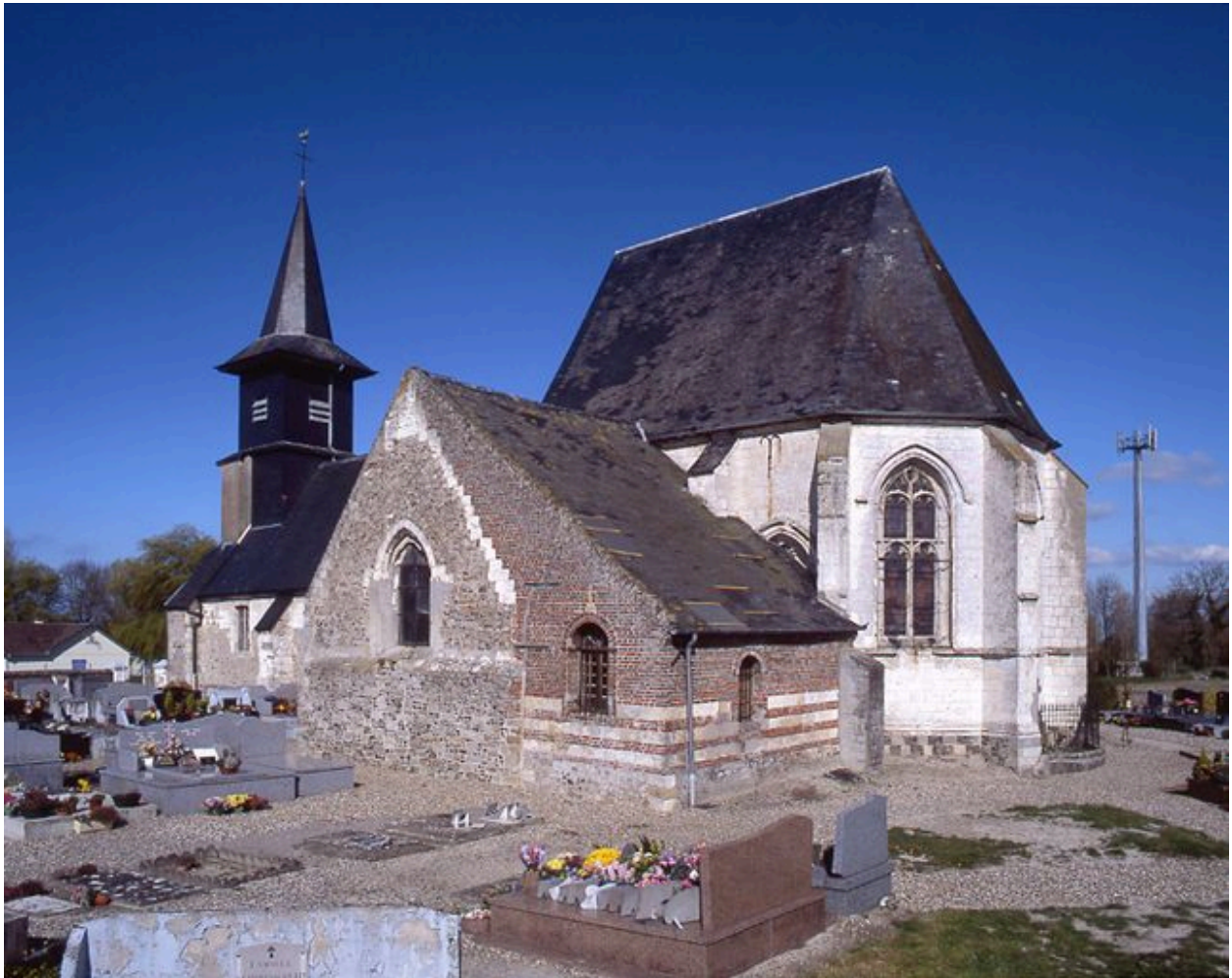
Vue depuis le sud-est.
