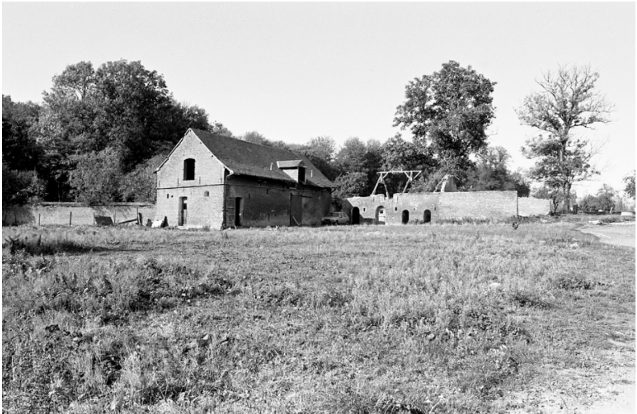
Deuxième ferme : étables ouest, vues depuis le sud-est.
