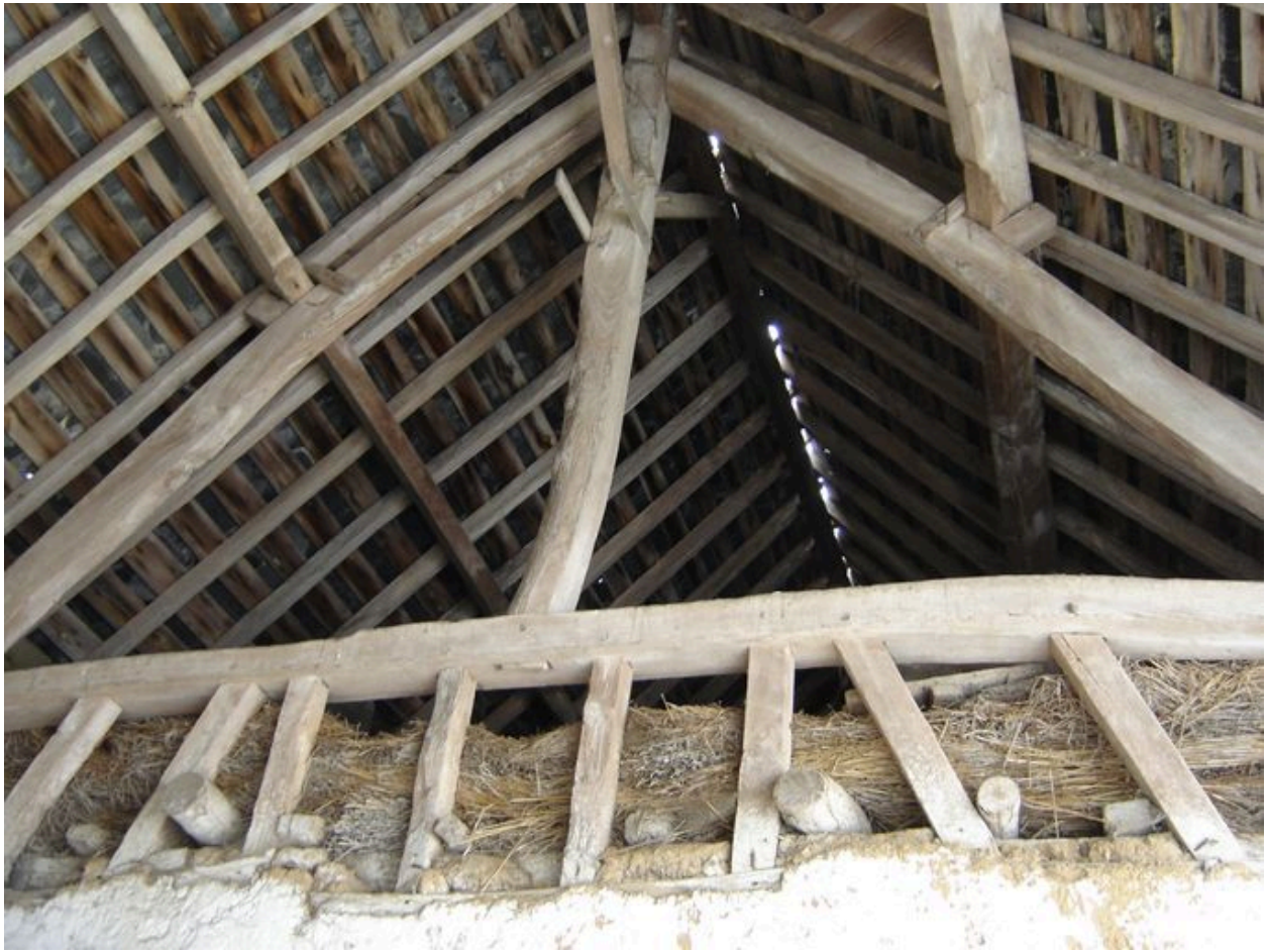
Détail de la charpente des étables.
