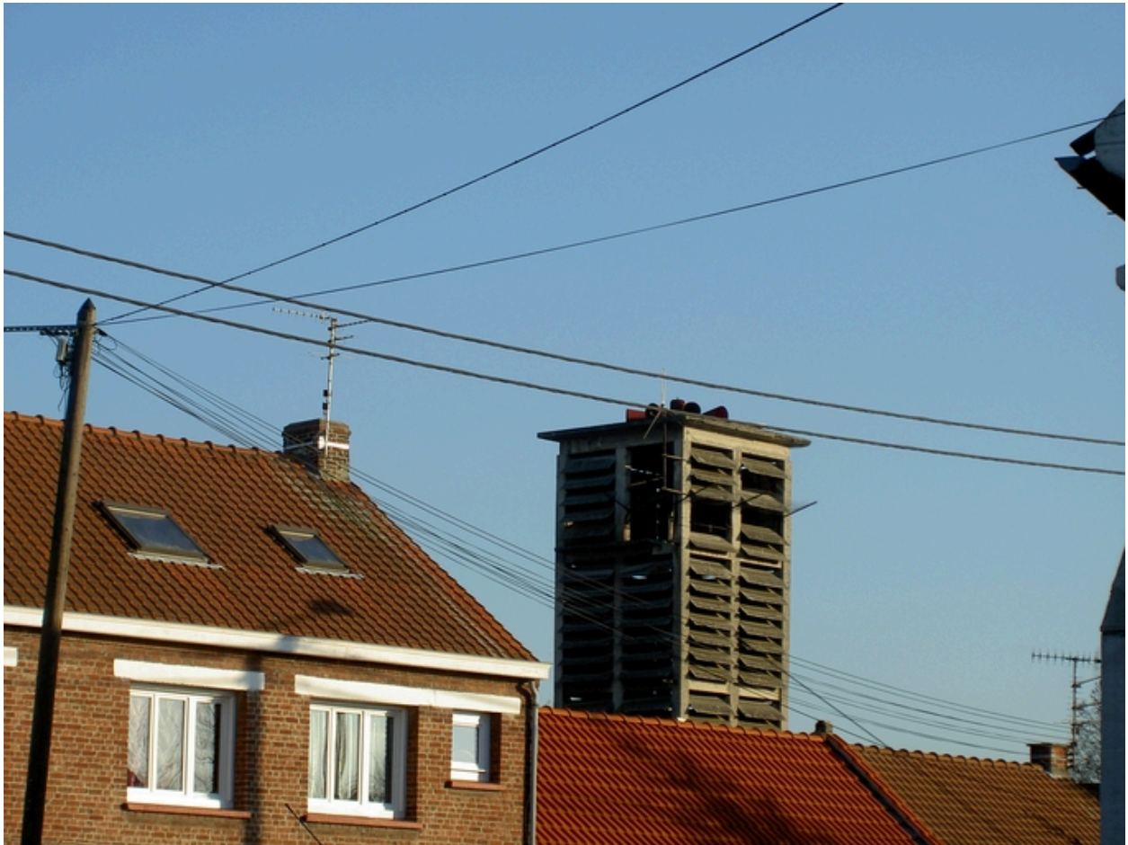
Vue générale de la tour des sirènes des pompiers.
