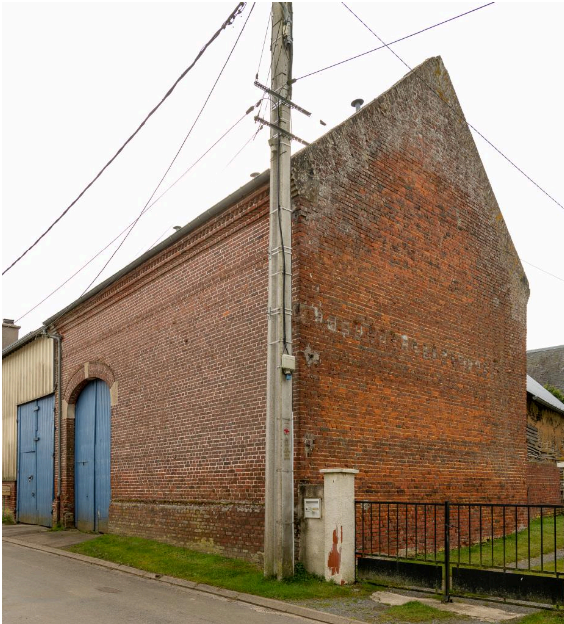
Grange en brique au n°15 rue de la Sablonnière, vue depuis le nord-ouest.
