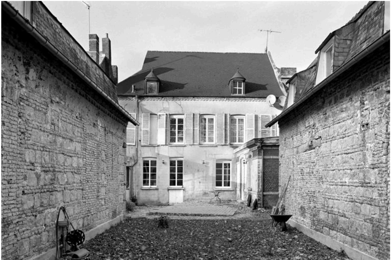
Vue de la façade sur cour du logis.
