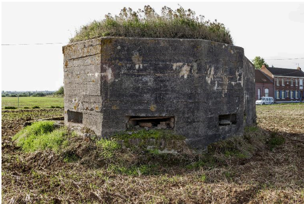
Vue de trois-quarts vers le sud-est
