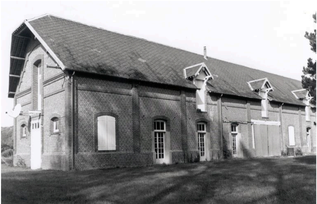
Les anciennes écuries et entrepôts.
