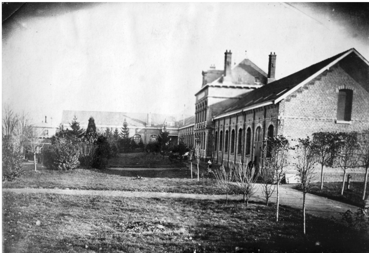
Cour et façade antérieure de l'usine, avant 1914 (AD Aisne).
