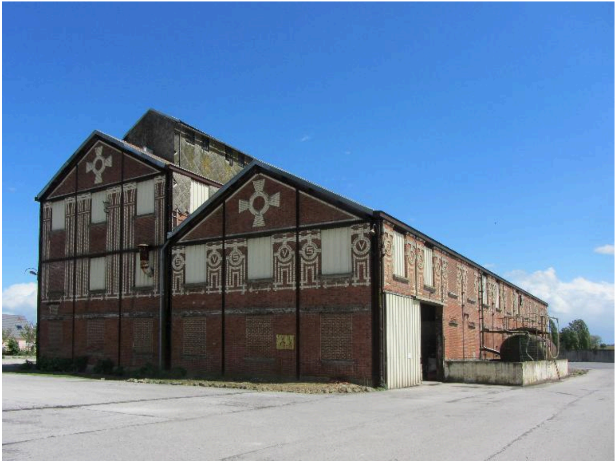
Vue d'ensemble de la façade ouest de la râperie.
