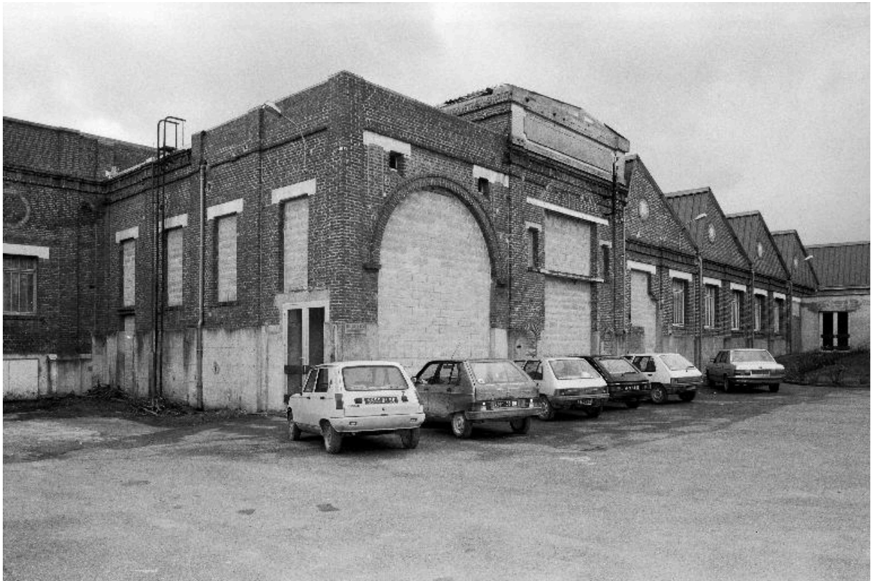
Anciennement chaufferie, salle des machines, atelier de fabrication. Élévation antérieure.
