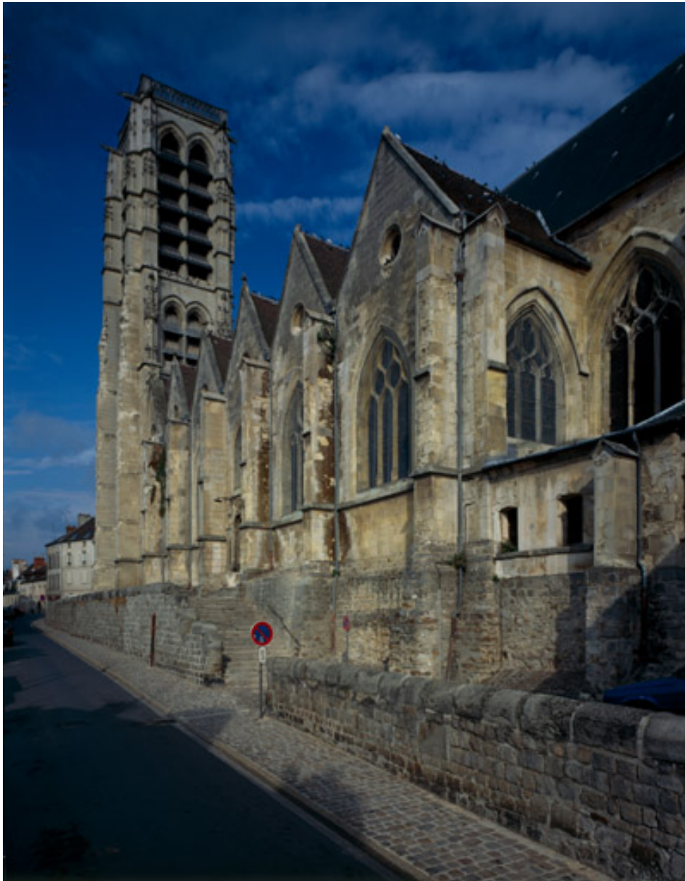
Vue générale du bas côté sud depuis la rue Saint-Crépin.
