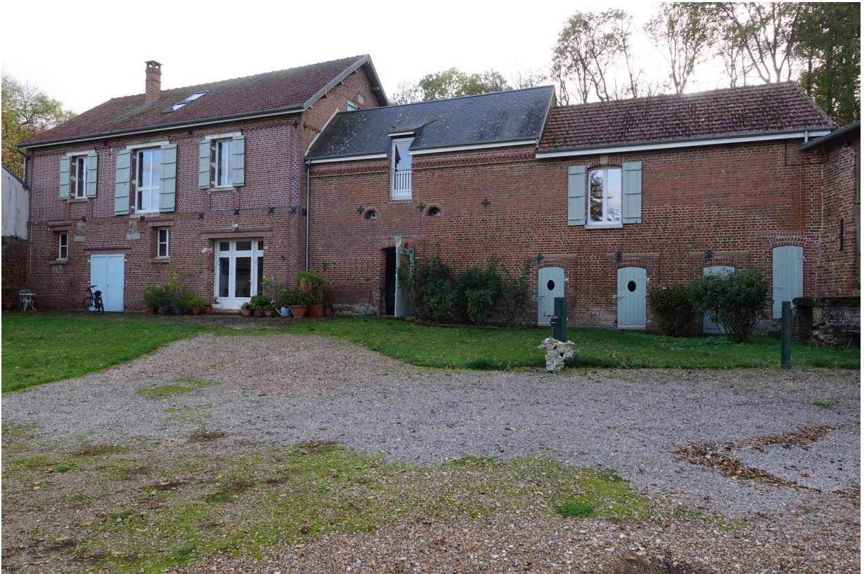
Ancienne grange et bâtiments d'élevage.
