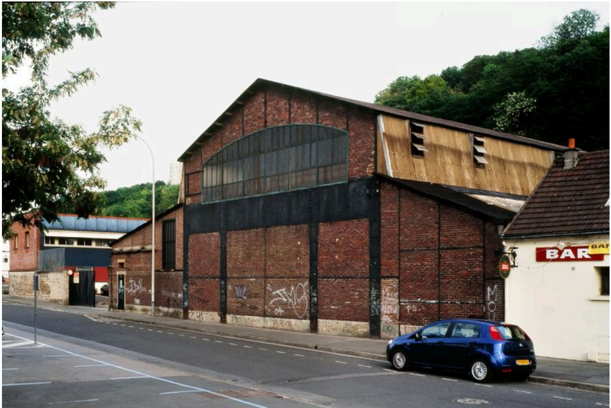
L'atelier construit en 1926 rue Michelet.
