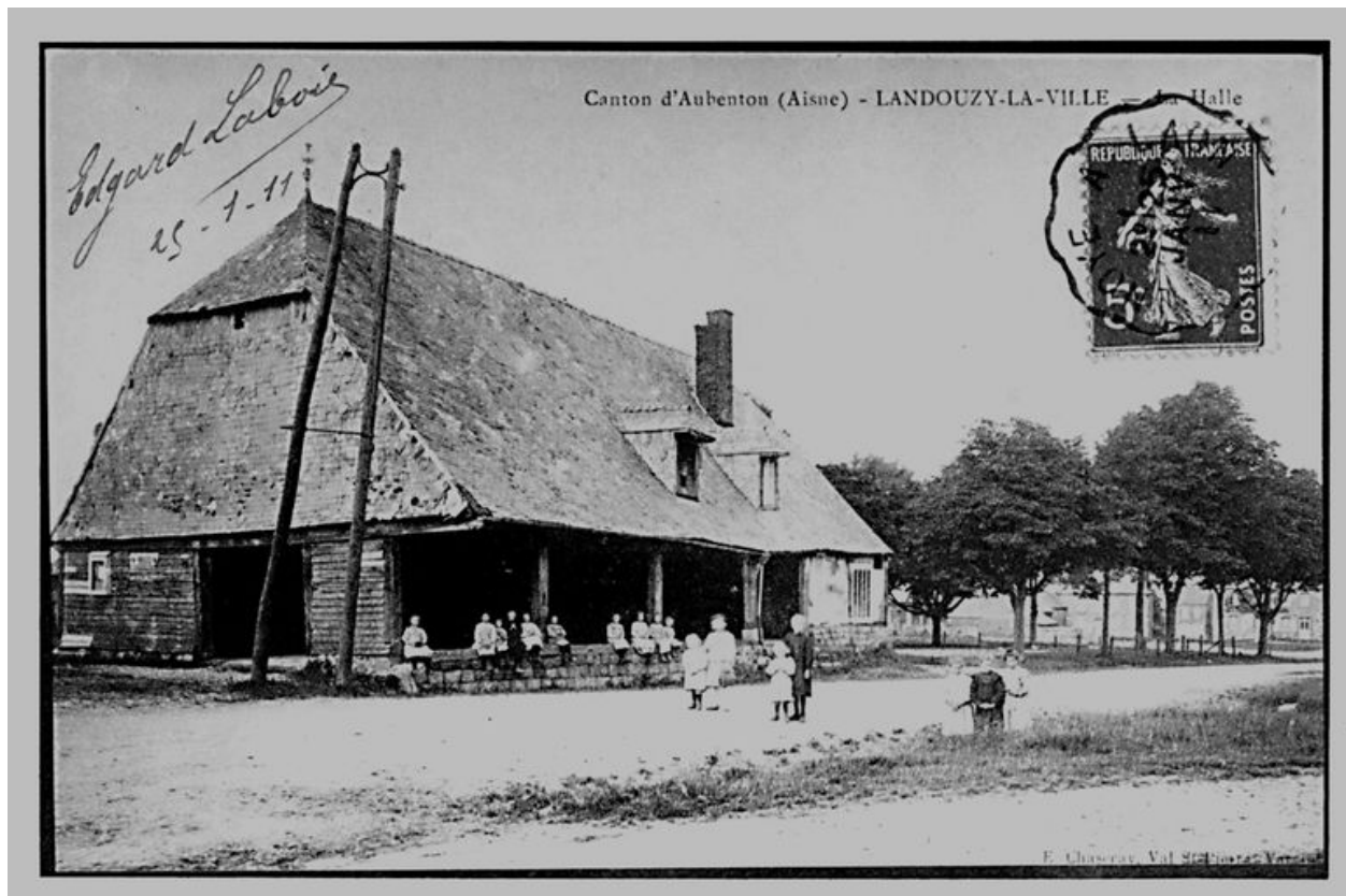
Vue ancienne depuis le sud-ouest (coll.part).
