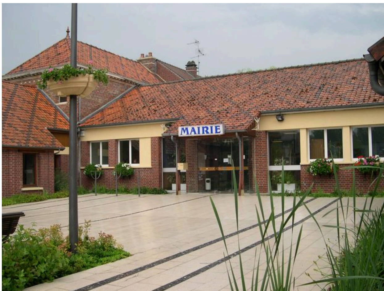
Vue depuis l'ouest.
