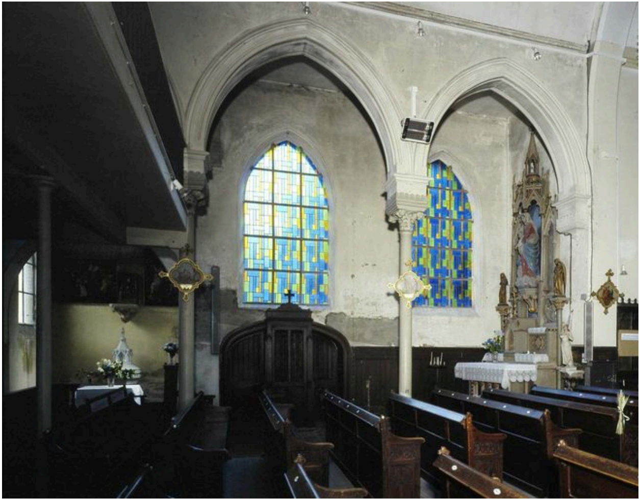
Vue intérieure : bas-côté nord.
