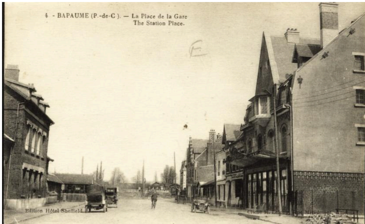
4. Bapaume. La place de la Gare - The station place. edition Hôtel Sheffield. Cliché R. Lelong, rue Miromont, Amiens. Carte postale, vers 1925 (coll. part.). Vue générale de place reconstruite.
