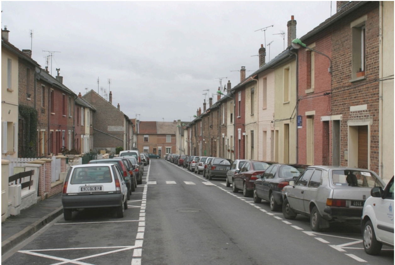
La cité Ducret, rue Albert-Daltroff.
