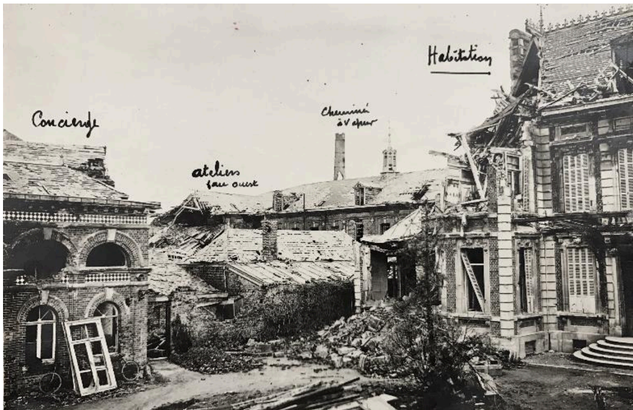
Etat des destructions de l'habitation et de la conciergerie, vue vers l'ouest (AD Somme ; 10 R 1276).
