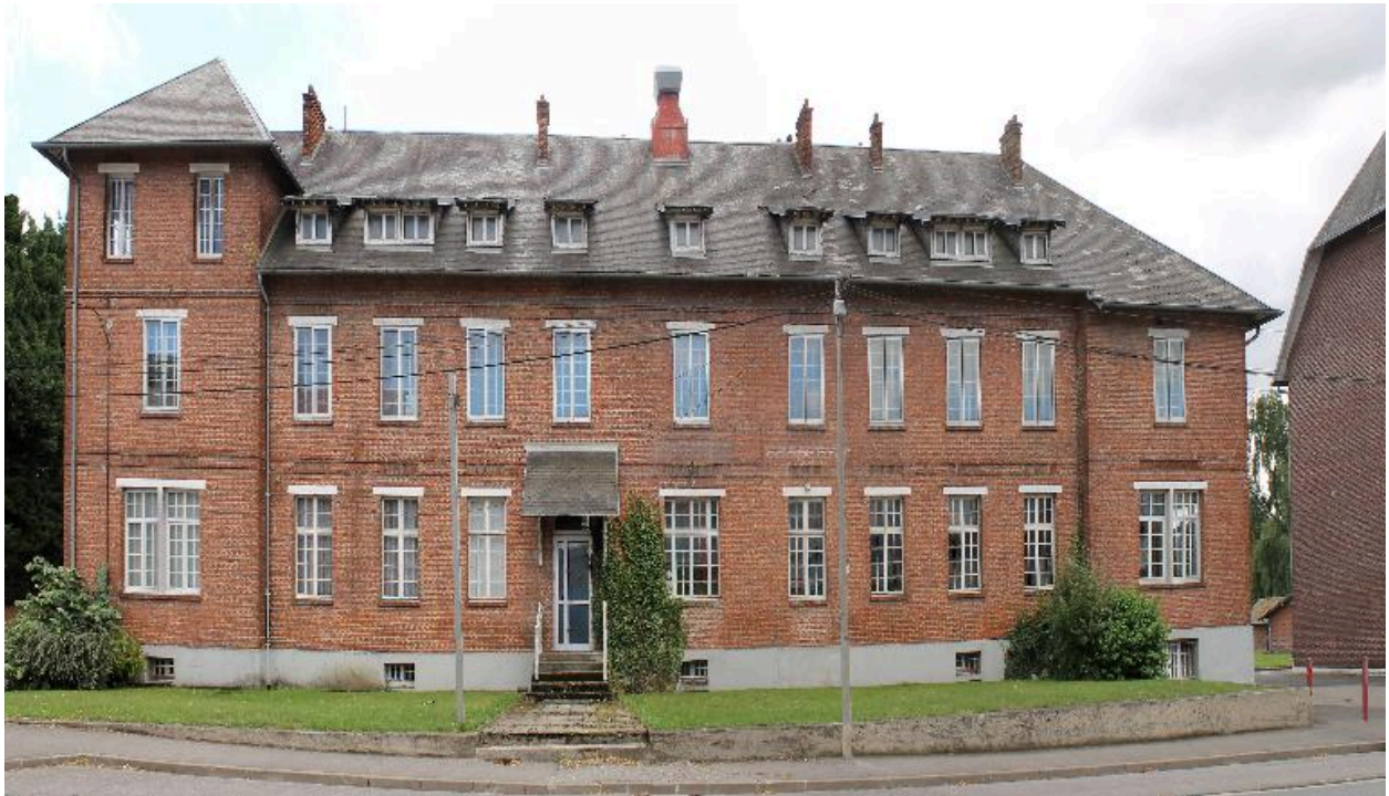
Façade sur rue, vue de face.
