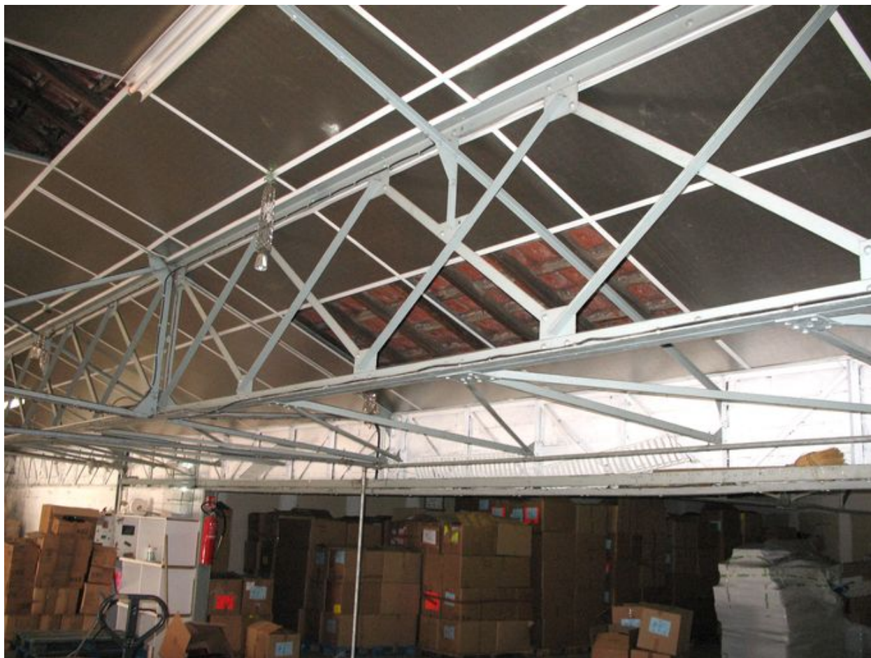
La charpente métallique et la couverture en tuile mécanique.
