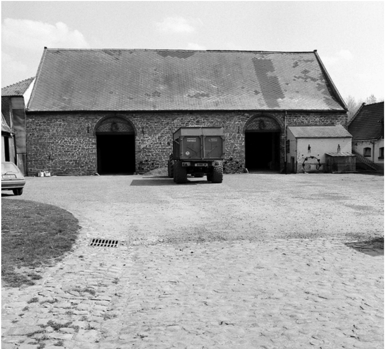
Vue générale de la grange.
