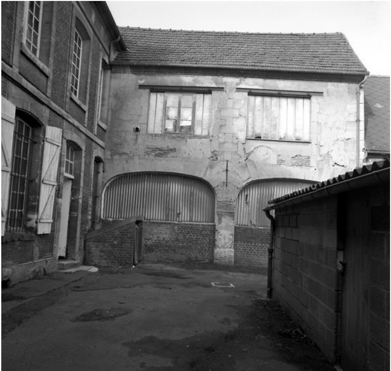
Atelier de fabrication, façade sur cour et aile en retour.
