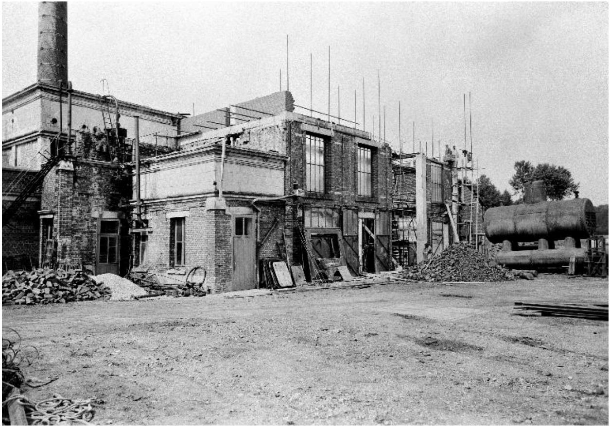
La chaufferie en cours de rconstruction. Juillet 1953 (coll. part.).
