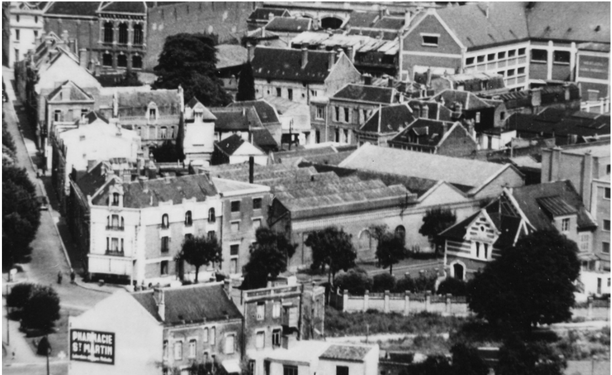
Vue aérienne du site dans les années 1950 (AD Aisne).
