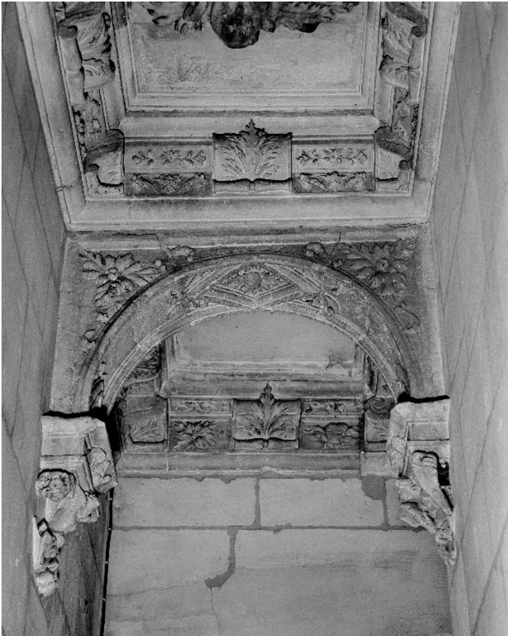
Vue d'un arc diaphragme.
