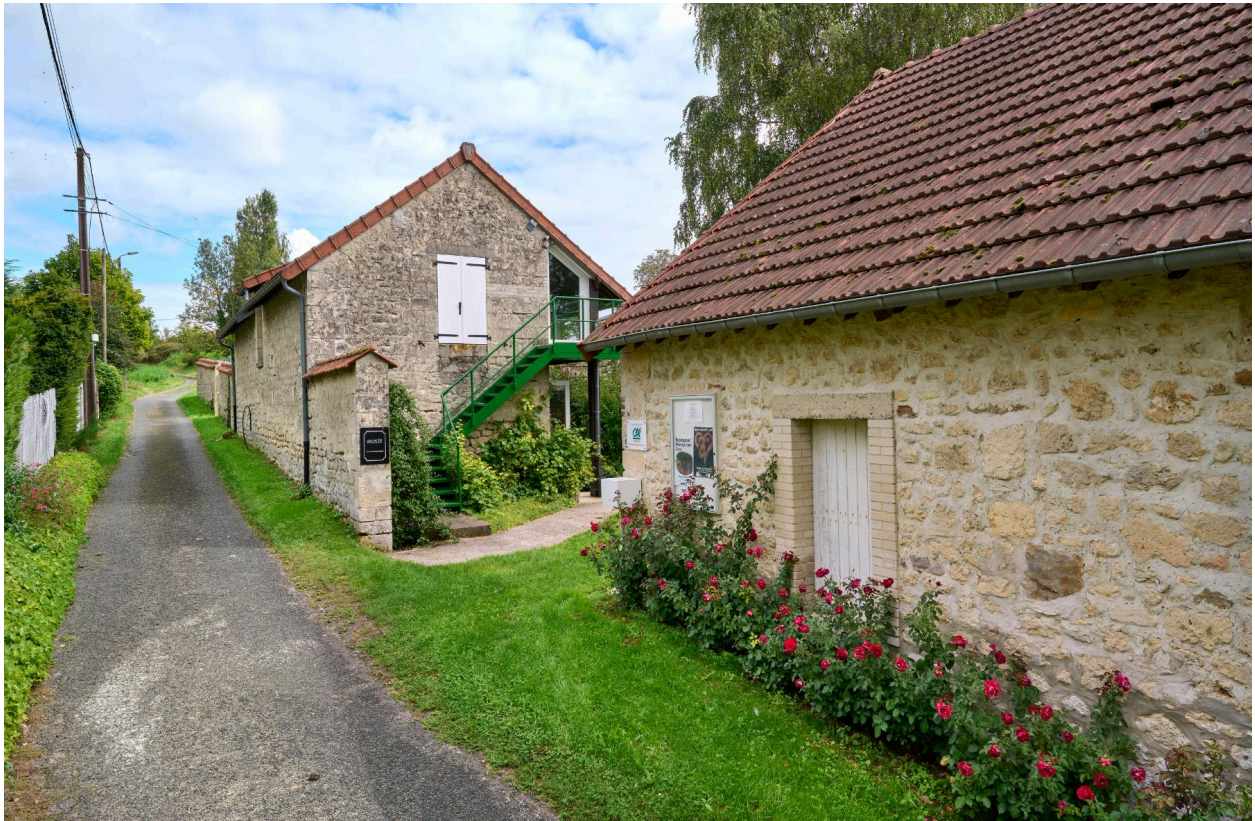
Accès à la cour de l'atelier, vue nord portail ouvert.
