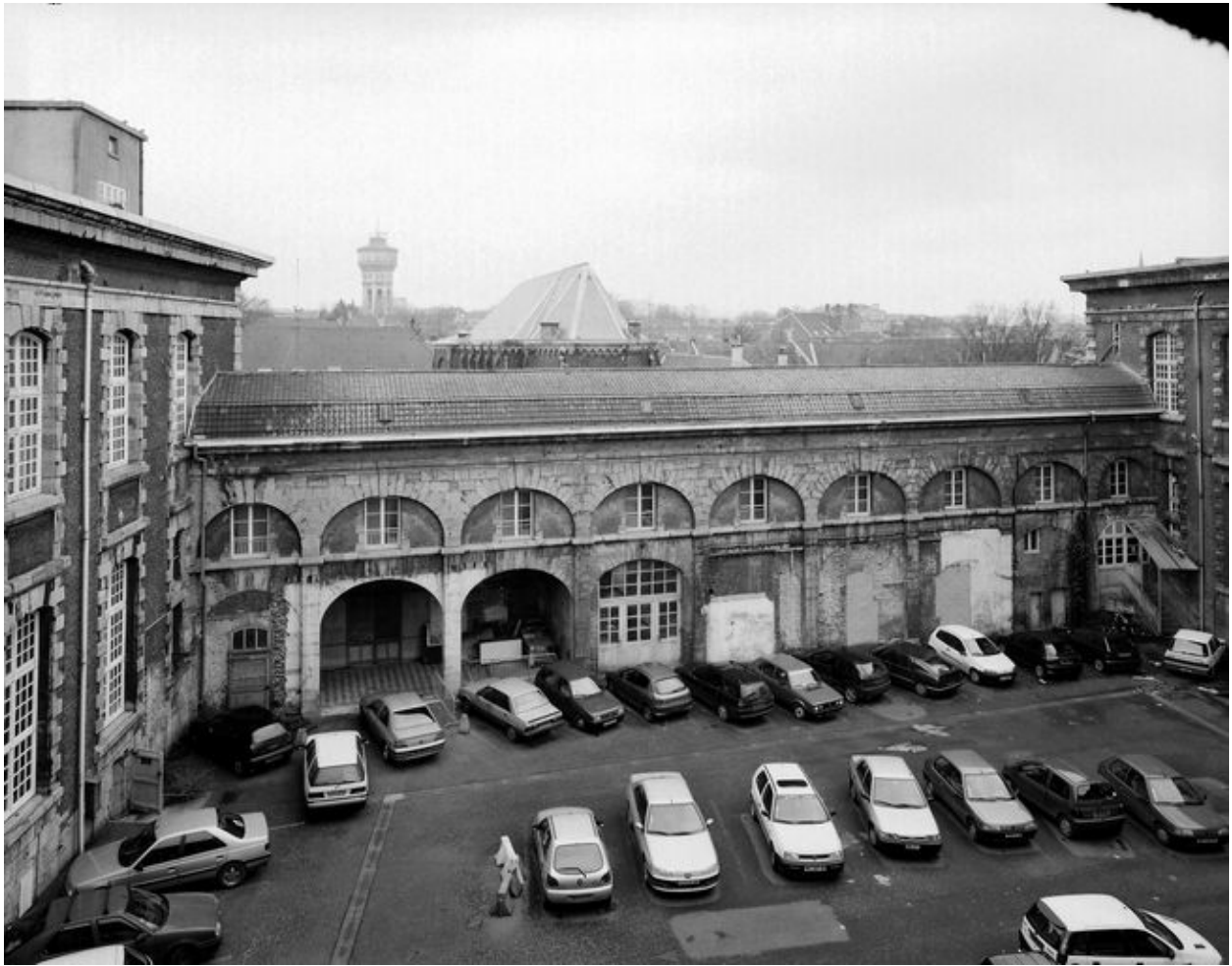
Cour des services, vue générale en regardant vers le corps de bâtiment fermant la cour sur son flanc droit.
