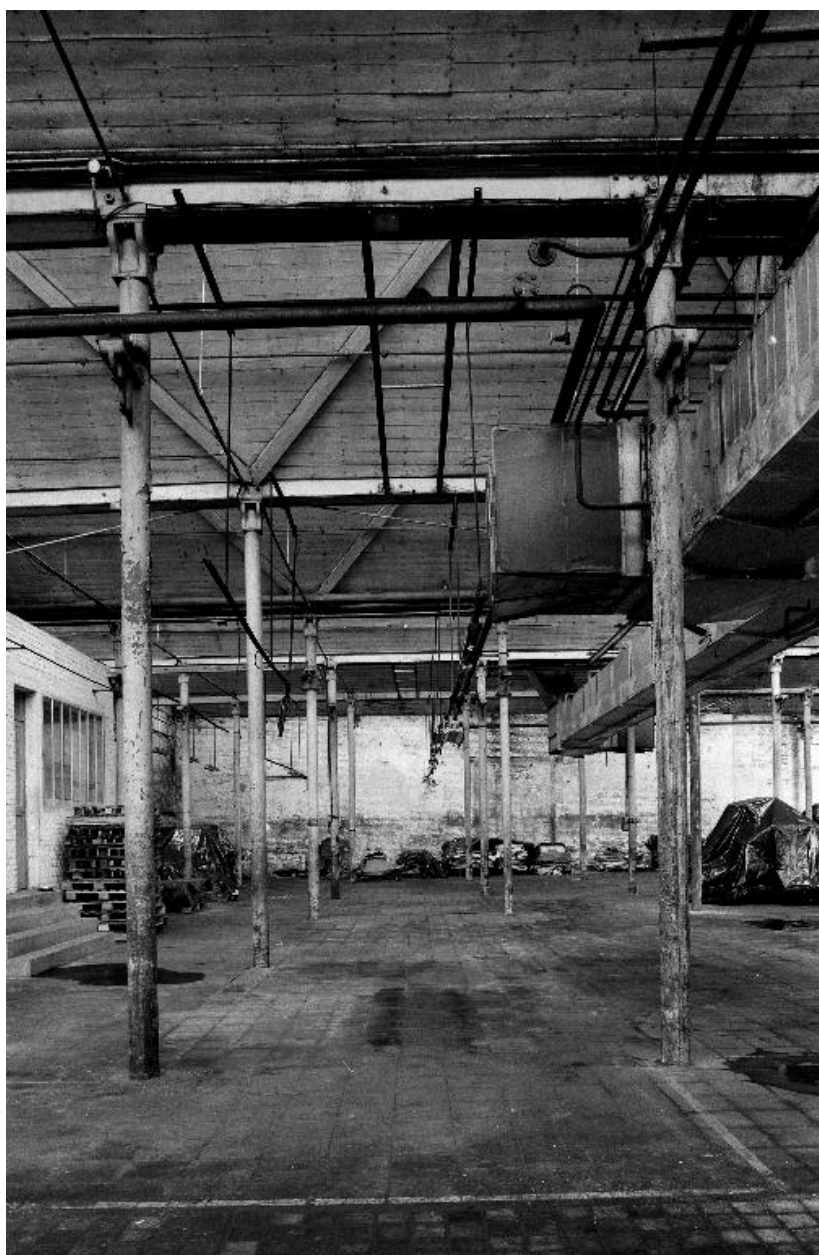
Atelier de préparation de la filature. Vue intérieure.
