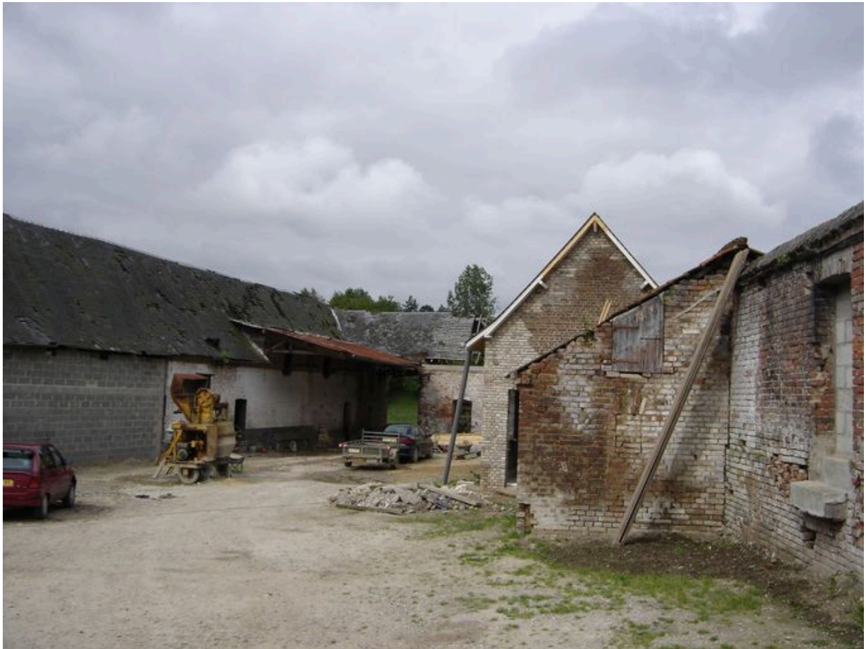
Vue des bâtiments en brique encore en place.
