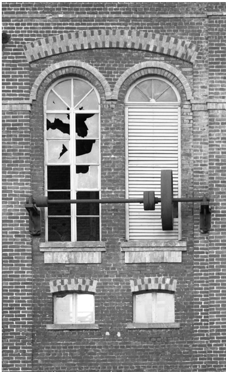
Détail de la façade de l'atelier de fabrication.
