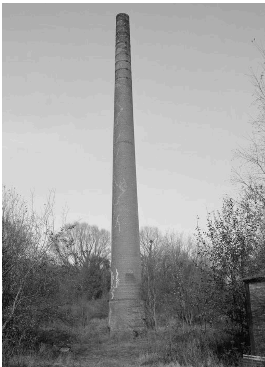
La cheminée d'usine.
