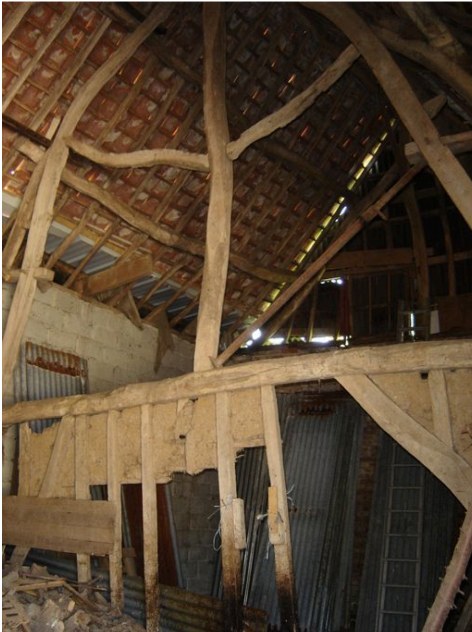
Vue intérieure des cloisons de la grange.
