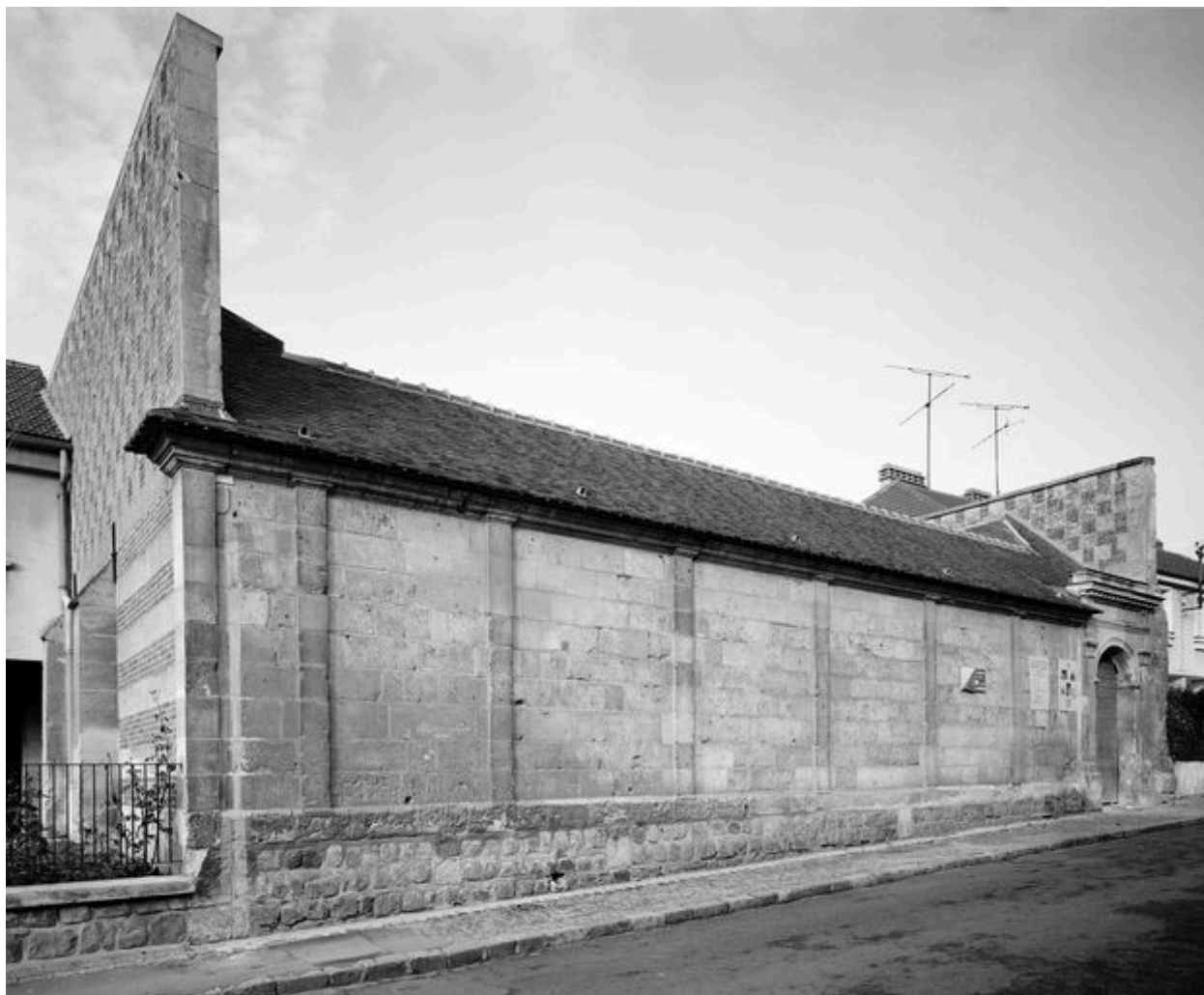
Cloître, élévation sur rue.
