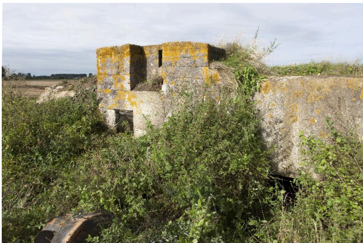
Elévation antérieure. Le poste de tir au centre et, à sa droite, l'entrée dans l'édifice
