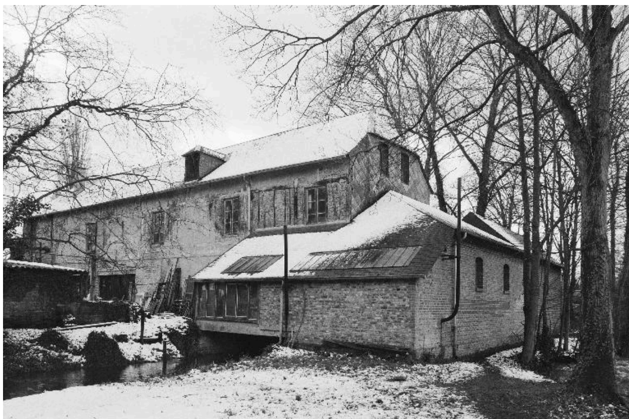
Atelier de fabrication, élévation postérieure.
