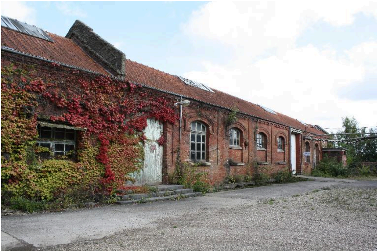
Façade sur cour des ateliers de tissage, état en 2011.
