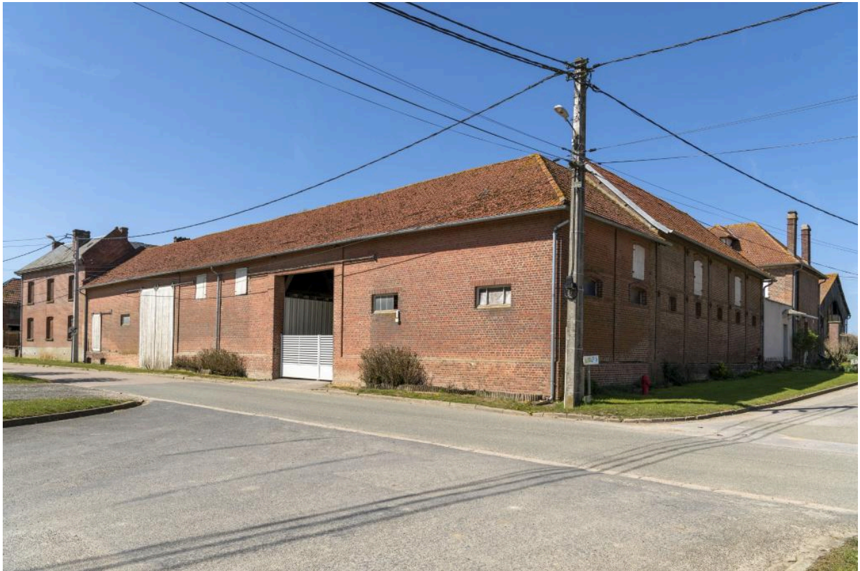
Ferme reconstruite après les bombardements de 1940, n°40 rue Principale, vue depuis l'est.
