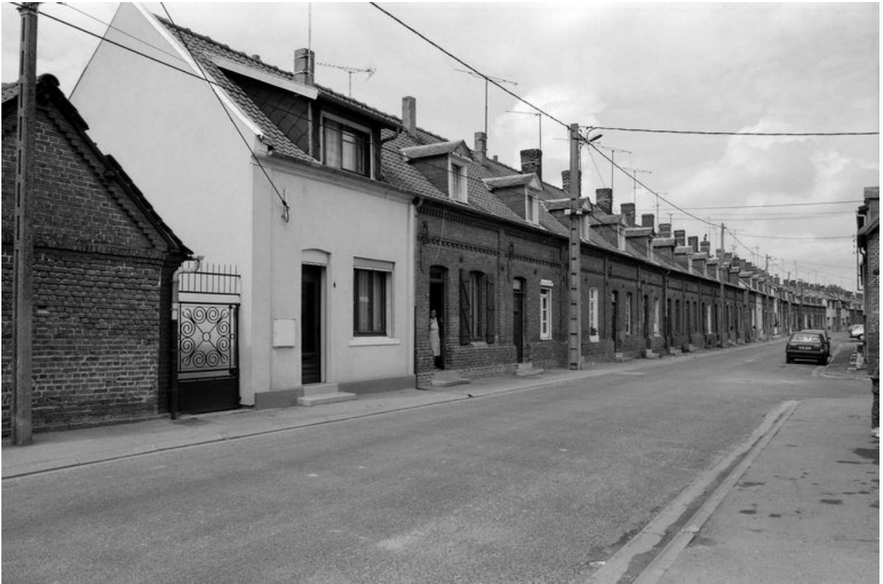
Vue des logements d'ouvriers (4 à 26 rue Georges-Outrebon), en 1991.
