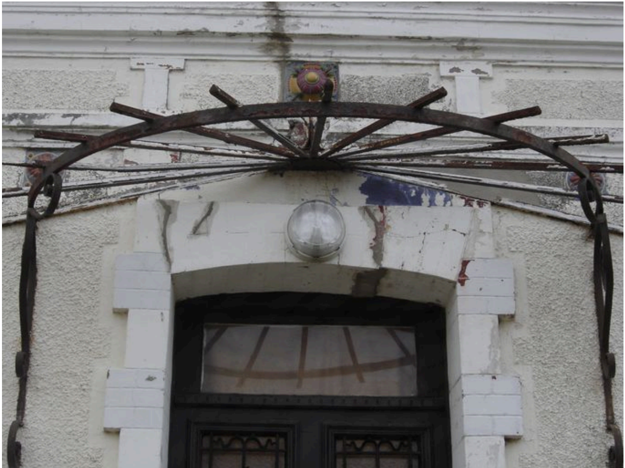
Vue détaillée de la marquise.
